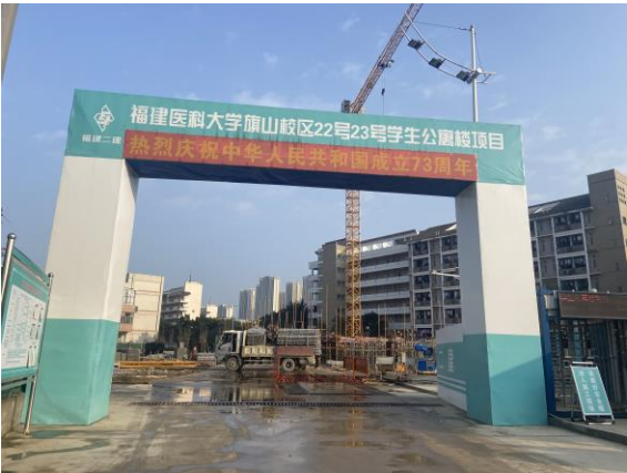
项目西侧施工出入口（洗车池）
