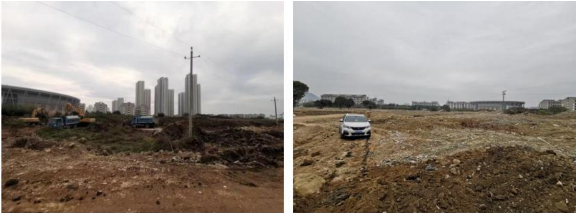
图 2.2-2 临时堆土场现场照片
