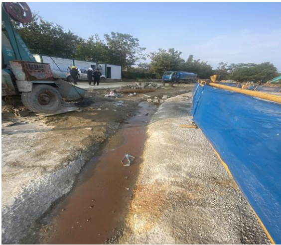
23 号公寓楼（西侧排水沟）
