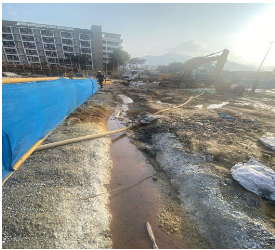
23 号公寓楼（北侧排水沟）
